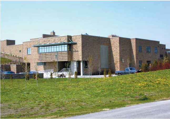
L'usine d'alimentation en eau d'Ajax sert 150 000 clients dans deux communautés.
