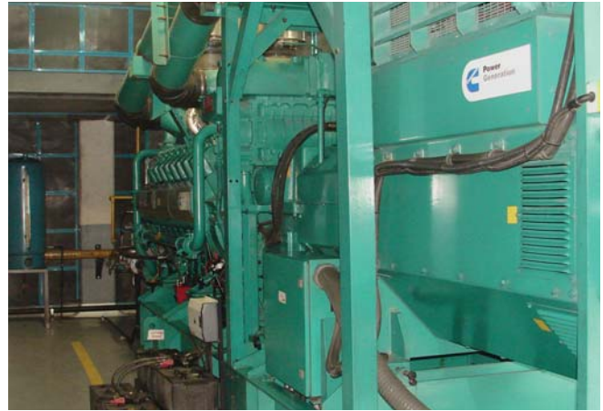
Al obtener tanto electricidad como calor del gas natural, la compañía gasta menos en energía que antes de instalar el sistema de cogeneración, y al mismo tiempo resuelve los problemas relacionados con la estabilidad del voltaje y reduce las emisiones totales.
