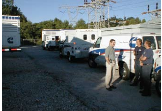
First Energy Corporation y Cummins Power Generation trabajaron juntas utilizando unidades Rental Power in situ para producir energía rentable para horarios punta.
