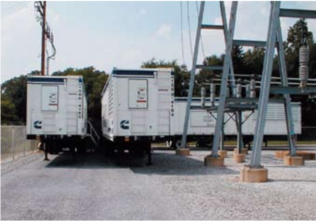
Las unidades Rental Power de Cummins Power Generation, de potencias de 750 kW a 2 MW, encajan fácilmente en las subestaciones.
