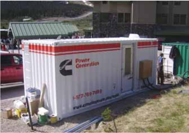
Une des trois unités électriques de location de 500 kW a été utilisée pour une alimentation de secours au Brewster Columbia Icefield Center.
