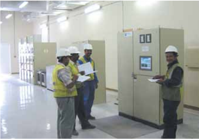
Cummins Power Generation fue el proveedor seleccionado tras demostrar su capacidad de cumplir con todos los requisitos de ejecución.
