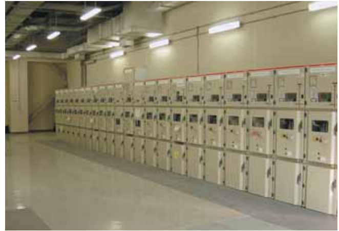
Las tres unidades de 2250 kVA con controles maestros digitales, junto con resistencias neutras de conexión a tierra, proporcionan energía de reserva de emergencia confiable al aeropuerto.
