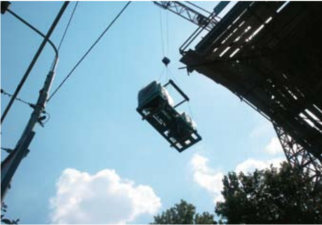
Se tomaron medidas especiales para maniobrar el inmenso conjunto generador dentro del sótano del teatro.
