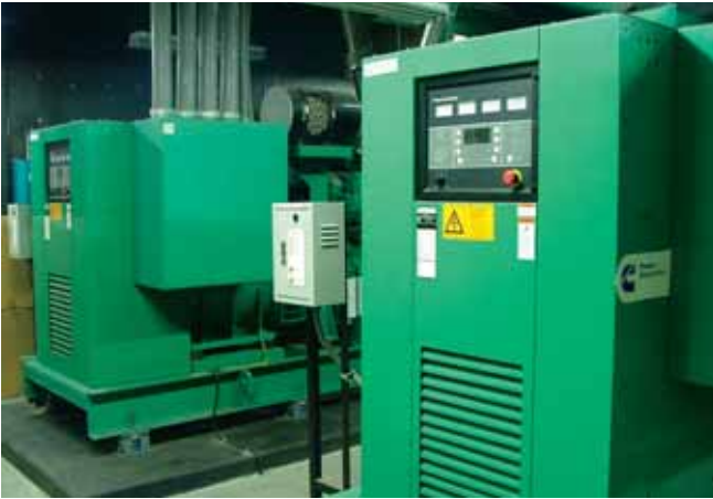
Generadores de Cummins Power Generation capaces de soportar cargas de alto contenido SCR.
