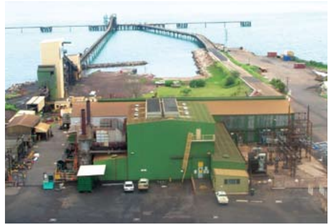
La central eléctrica Groote Eylandt no solo abastece a la mina de manganeso, sino también a la ciudad principal de la isla, Alyangula.
