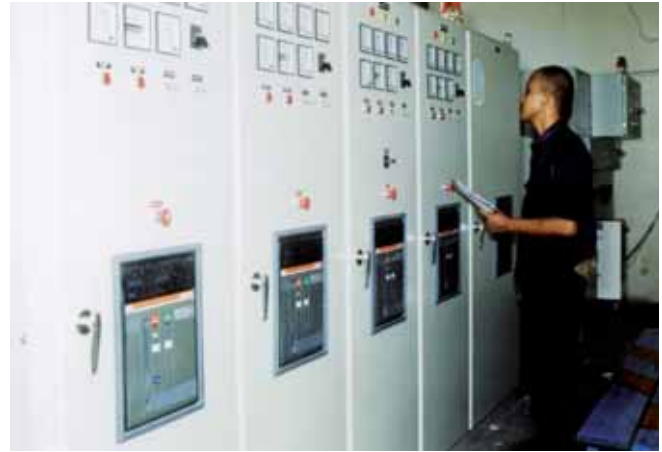
Los controles de puesta en paralelo facilitan la sincronización de los conjuntos generadores con la red pública de suministro.
