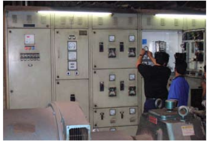
Técnicos dando los últimos toques de acabado al cableado de control.
