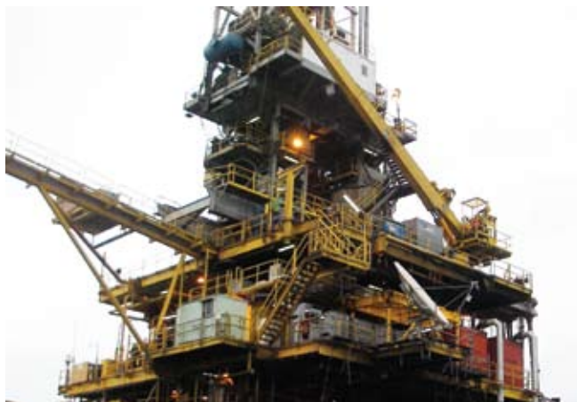
Una de las plataformas de PEARL Energy.
