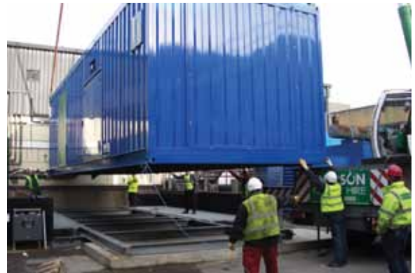
Les équipements ont dû être mis en place dans un espace offrant très peu de marge de manoeuvre, l'équipe de Cummins Power Generation a coordonné les opérations délicates de grutage.
