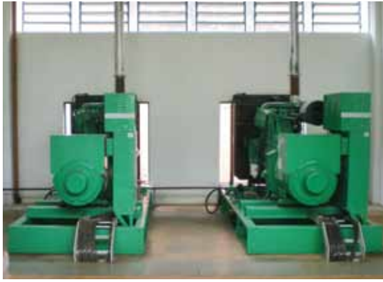
Arriba, los 2 Grupos Generadores modelo C400 D6, que garantizan la reducción de los gastos con energía durante el horario de punta y energía continua en caso de emergencias. El sistema es controlado por los paneles DMC1000 (a la derecha).
