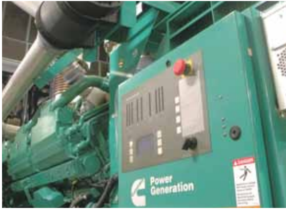
Arriba, panel de control PowerCommand™ de uno de los Grupos Generadores C2500 D6. A la derecha, detalle de parte del sistema de enfriamiento.
