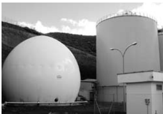
Digestor de basura en Salto del Negro, Las Palmas de Gran Canaria, Islas Canarias
