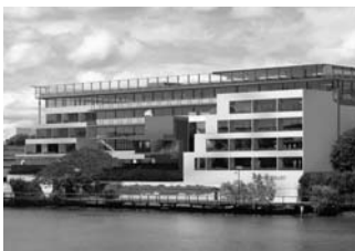
Planta de energía de metano de vetas de carbón de Moronbah, Queensland, Australia
