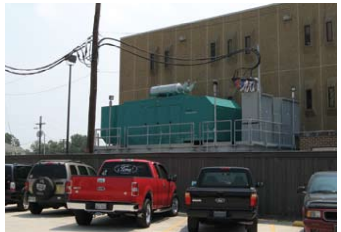
La instalación de esta plataforma aprovecha un espacio particular creado por un muro de contención en un área urbana.
