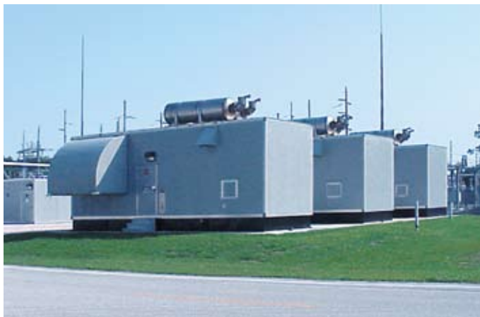
Un fabricante de instalaciones de semiconductores en el sur de Florida, confía en los entornos de aluminio pintado para proporcionar protección contra la corrosión y el clima.
